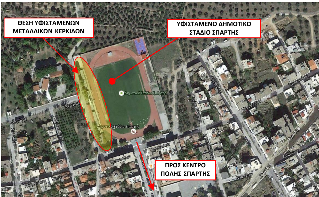
Εικόνα 1. Γενική άποψη χωροθέτησης υφιστάμενων μεταλλικών κερκίδων στο Δημοτικό Στάδιο Σπάρτης
